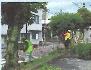
植栽・樹木の剪定作業 公民館裏 土手の草刈り
