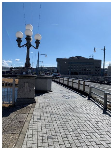
現在の多治見橋 写真左が平成5年設置の照明灯
