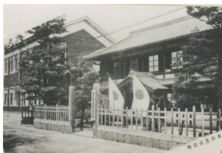
明治26年建設 町役場時代
