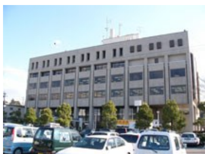
昭和49年建設 現在の市役所
