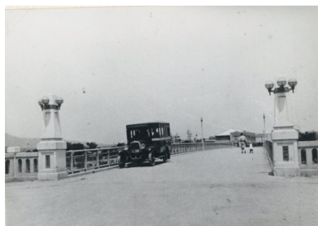
架橋すぐの昭和橋
